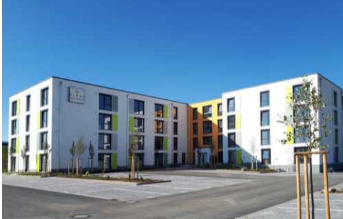
Abbildung 6 Außenansicht Flexi Wohnen (Quelle: RAAB Baugesellschaft)
