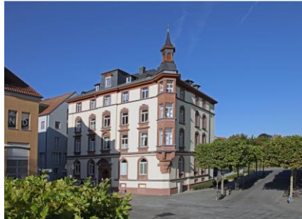
Abbildung 5 Gebäude in der Rückertstraße 27 (Quelle: Stadt Schweinfurt)
