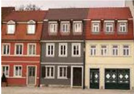
Abbildung 3 Am Zeughaus 22-26 (Quelle: Sanierungsstelle der Stadt Schweinfurt)
